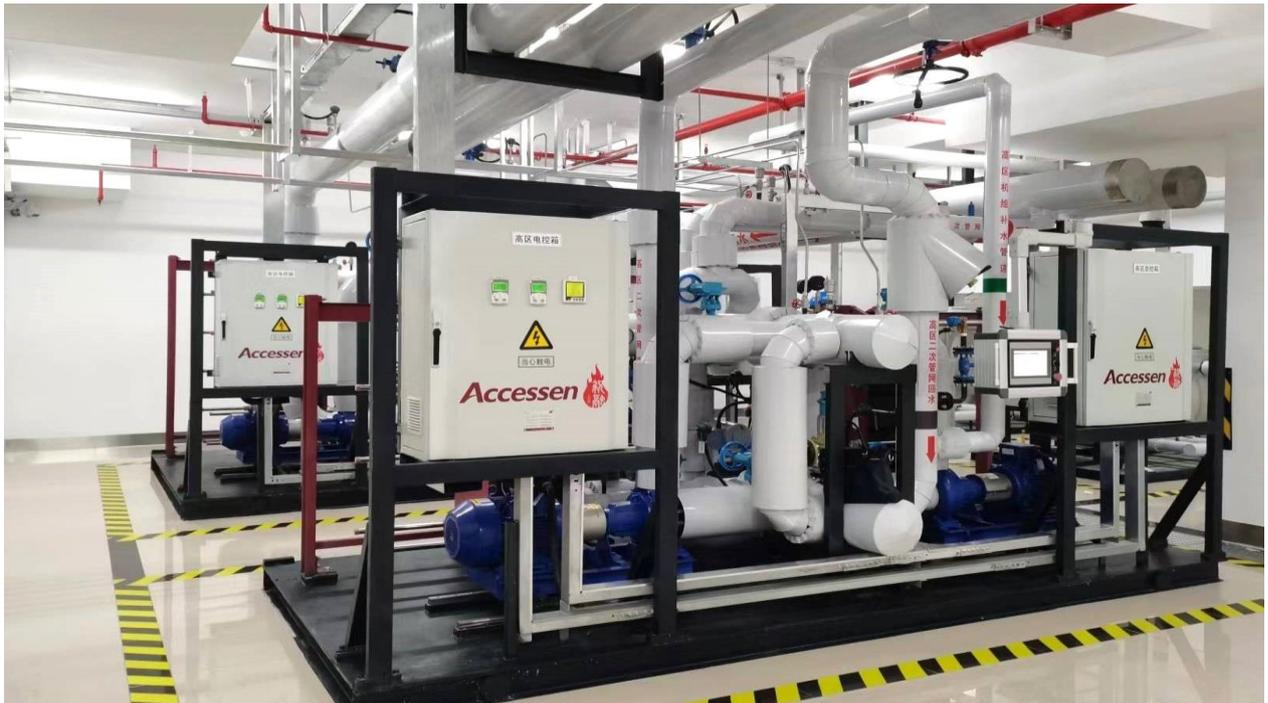
经过华能日照热力多方考察及论证后，最终在传统板式换热机组的基础上精简采用了6个规格的标准模块化机组系列，此标准系列换热模块通过单台使用、两台并联使用及三台并联使用，达到覆盖85%以上供热工况，解决热力企业使用的设备型号及备品备件过多、管理成本过高、运行成本过大的缺点，标准化后各个热力站设备互换性有了很大的提升，通过标准生产和供应实现热力站的快速安装和投运。
